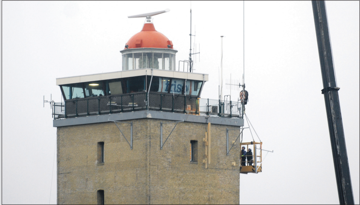
WEST-Terschelling - De voorbereidingen voor de renovatie van de vuurtoren Brandaris zijn in volle gang. Sinds gisteren staat een telekraan van KTF op het Brandarisplein. Deze steekt ver boven de 42 meter hoge vuurtoren uit. Personeel van de Friso Bouwgroep uit Sneek heeft inmiddels grote beugels aan de buitenkant van de toren geplaatst. Met de kraan worden daar vandaag delen voor een speciale hangsteiger op getakeld. Meer op pagina 7. (Foto: Jan Heuff)
